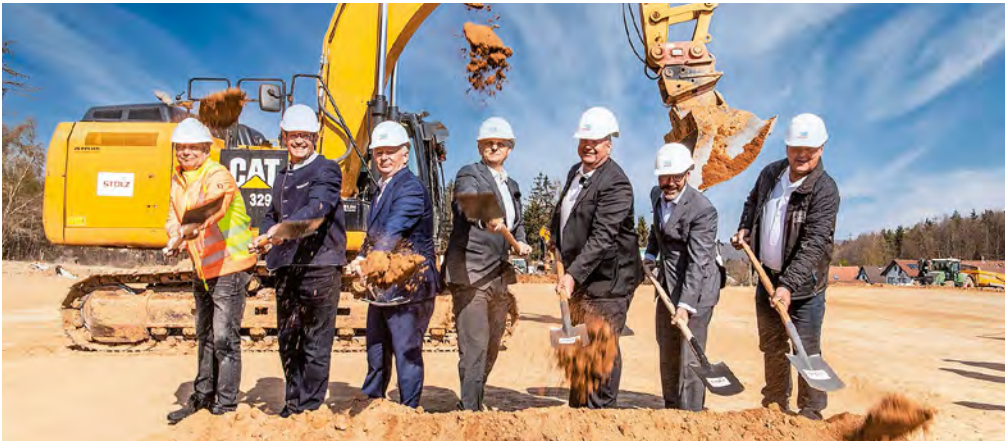
Die Hanse-Haus-Verantwortlichen beim Spatenstich für das neue Werk IV. Insgesamt investiert das Unternehmen rund 37 Millionen Euro in den Ausbau der Produktion am Standort Oberleichtersbach.
