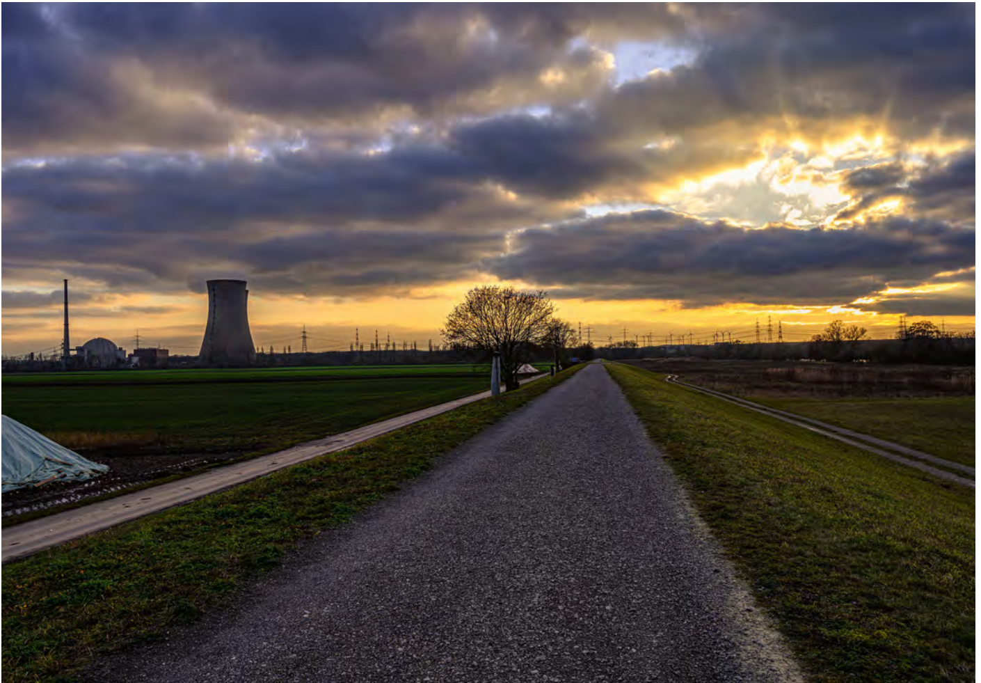
Das Kernkraftwerk in Grafenrheinfeld ist seit 2015 vom Netz, seit 2018 wird das KKW Schritt für Schritt zurückgebaut. Im Juli 2024 sollen dann die Kühltürme gesprengt werden. Spätestens ab 2035 soll auf dem Gelände wieder Gras wachsen.
