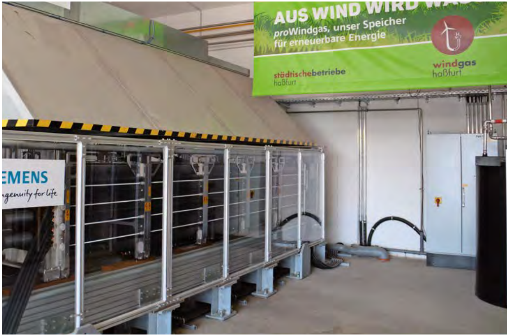
Der Elektrolyseur. Hier entsteht aus Wasser und grünem Strom Wasserstoff. Der Wirkungsgrad beträgt bei Rückverstromung rund 45 bis 55 Prozent. Foto: Marcel Gränz
