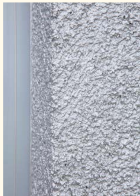
Der Putzanstrich aus Knauf Fassadol Metallic harmoniert mit ihrem metallischen Glanz sehr gut mit der Blechfassade des darunter liegenden Industriegebäudes. Fotos: Knauf/Bernd Ducke
