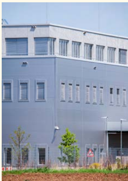
Vor den Toren Münchens hat Paulaner eine hochmoderne Brauerei gebaut. Eines der Werksgebäude erhielt ein zusätzliches Staffelgeschoss mit einer Fassade in Knauf Außenwand-Technologie.
