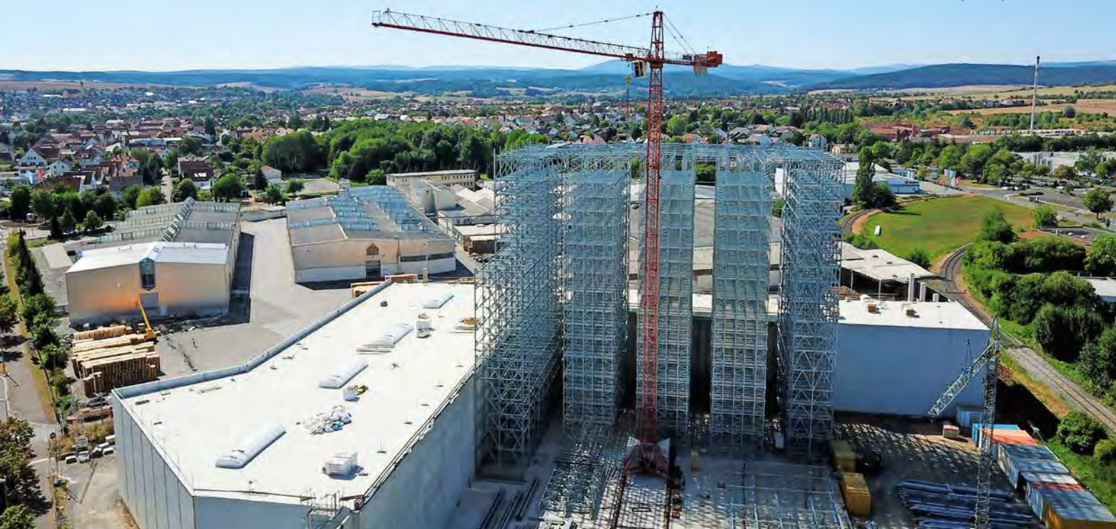
Eingerüsteter Bau: das Hochregallager in Bad Neustadt. Foto: Kunert-Gruppe
