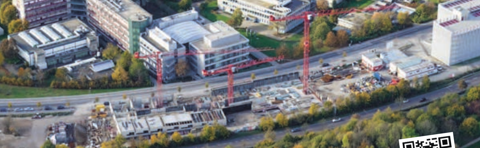
Neubau (Rohbau) eines Forschungsgebäudes an der Rheinisch-Westfälischen Technischen Hochschule Aachen
